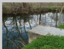
Captage dans la Dronne
